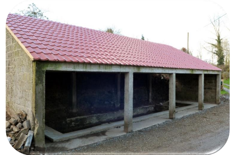
Le lavoir du Porjou en cour de rénovation
